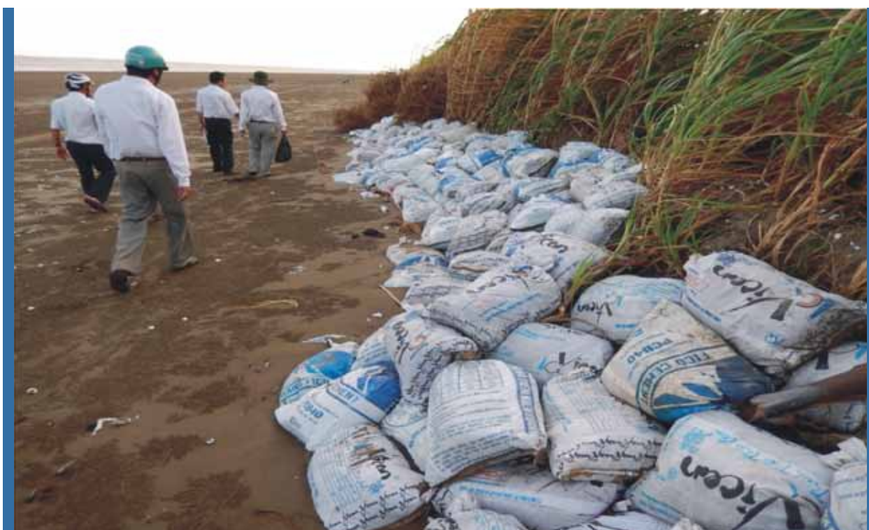
Hình 19: Chi tiết chống xói mòn tại địa điểm 2, phần trung tâm
