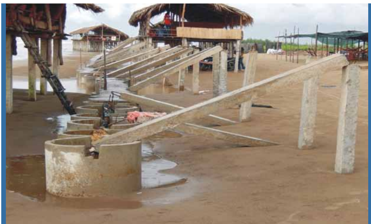
Hình 35: Chống xói mòn tại địa điểm 6, phần phía bắc
