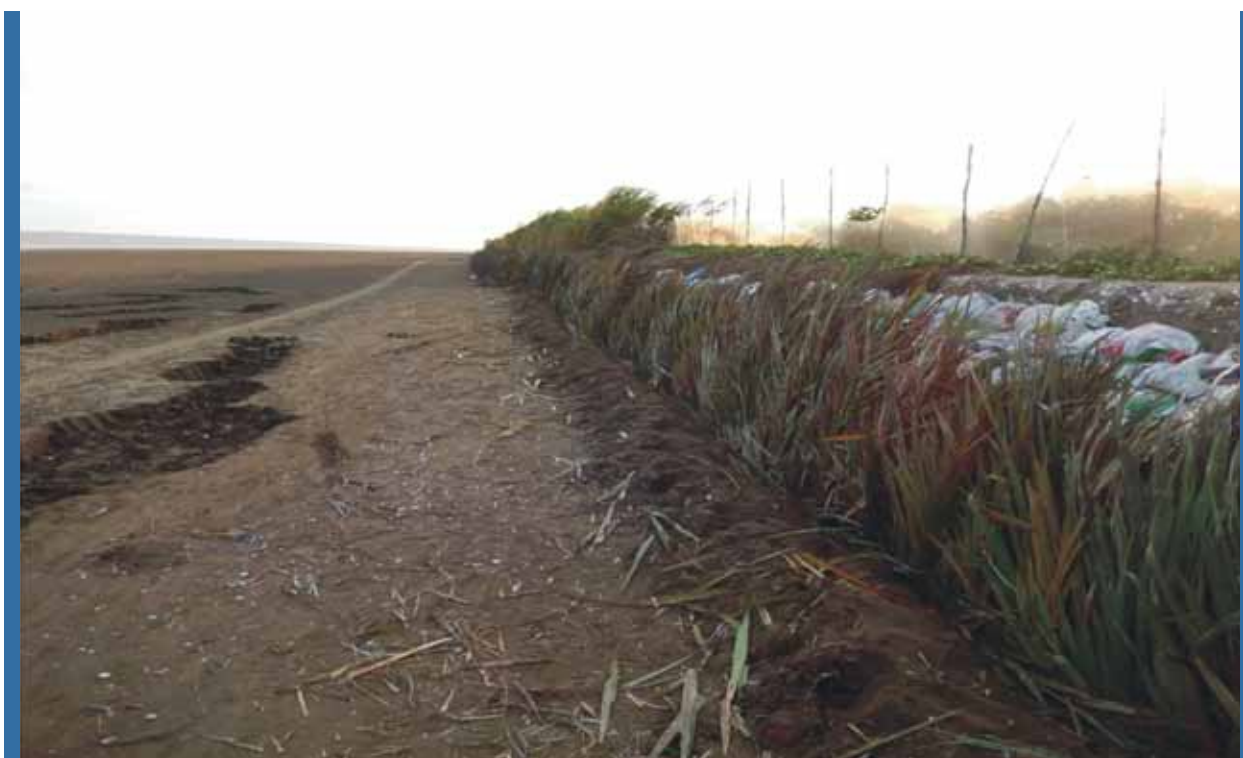
Hình 18: Chống xói mòn tại địa điểm 2, phần trung tâm
