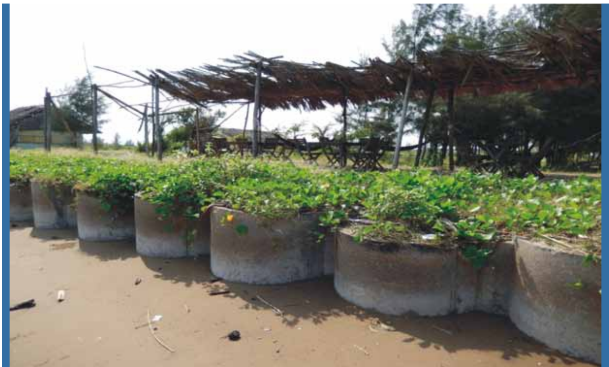
Hình 22: Biện pháp chống xói mòn cục bộ tại địa điểm 3, phần phía đông
