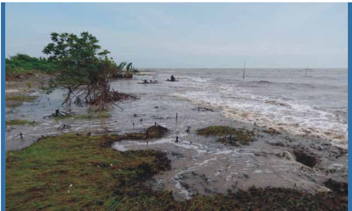
Hình 27: Đường bờ tại địa điểm 4 bao gồm cạnh bị xói mòn, phần phía đông, hướng quan sát phía đông bắc
